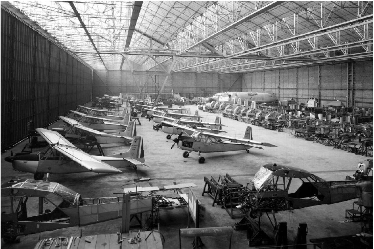
La chaîne de production des Nord 3400 aux Mureaux (photo Pierre Renaud).
